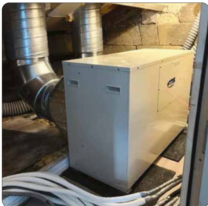
Esempio di installazione di un Elfo3-24 in sottotetto con convogliatore R-552230 e uscita a tetto.
