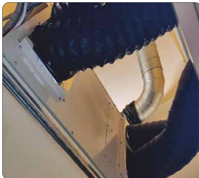
Esempio di installazione di un Elfo-18 con tubazioni flessibili che permettono un adattamento ottimale.
